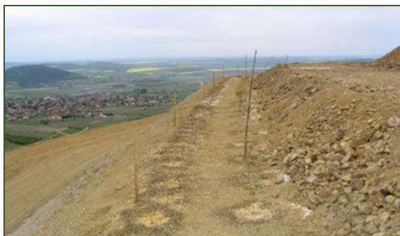
13. ábra: egy sor cserje és egy sor fa ültetése mikroteraszra
