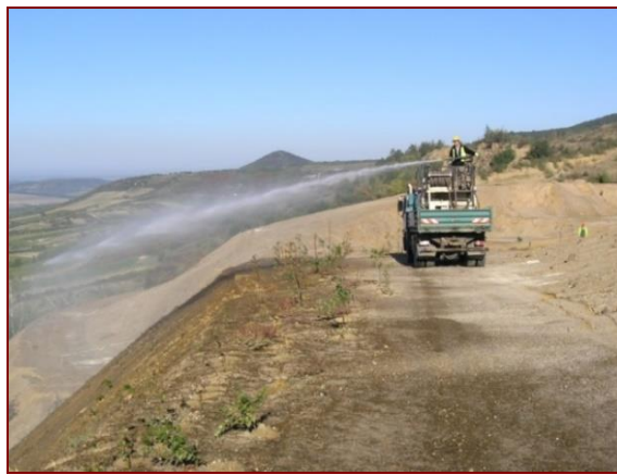
22. ábra: vízsugaras fűmagvetés széles terasról lefelé
