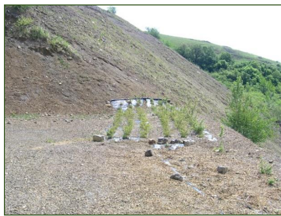
24. ábra geotextíliába ültetett cserjefolt a Dorgó-hányó széles-teraszának fordulójában
