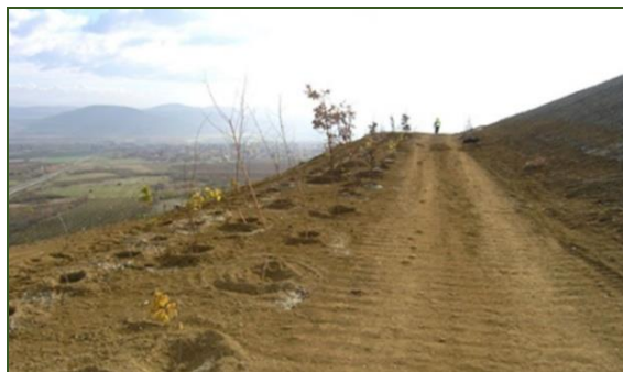
14. ábra: egy sor cserje és két sor fa ültetése széles teraszra (kivitelezés közbeni fotó)
