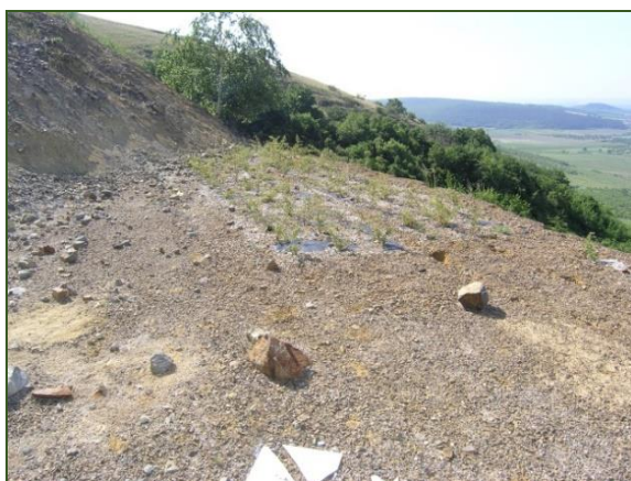
23. ábra geotextíliába ültetett cserjefolt a Dorgó alsó-hányó platójának sarkában
