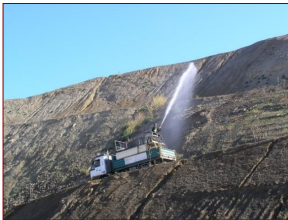
21. ábra: vízsugaras fűmagvetés széles terasról felfelé
